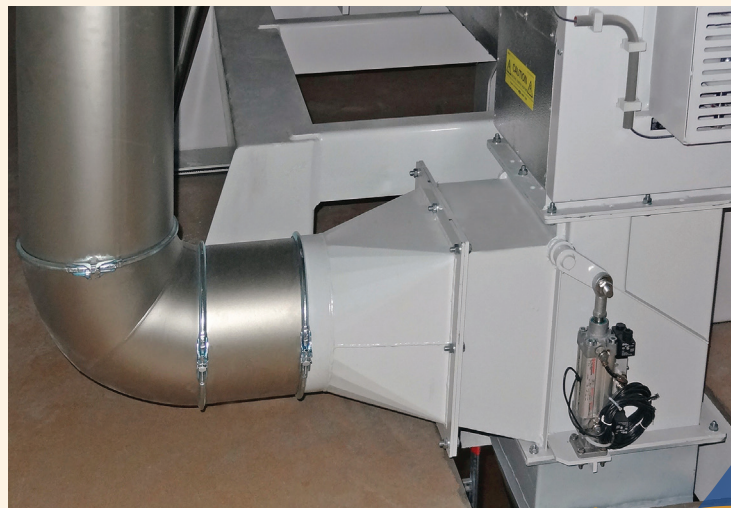
Systeme: vanne d'évacuation d'air chaud
